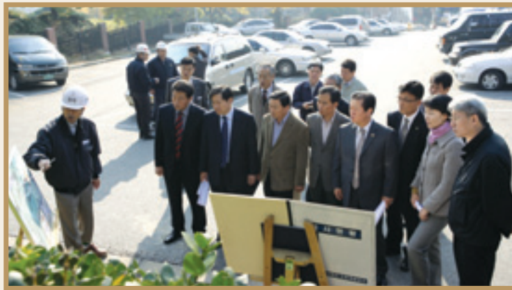
▲공원로 확장공사 현장
