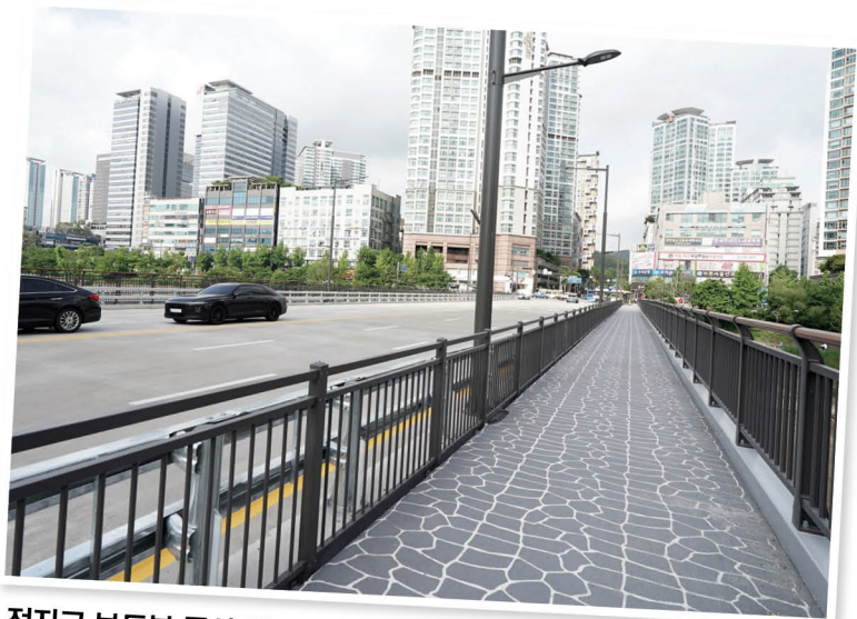
정자교 보도부 공사 완료
