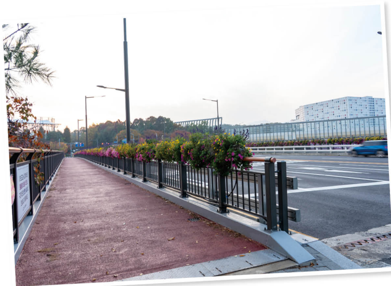
사송교 보도부 공사 완료
